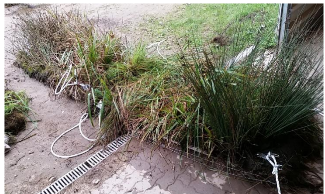
Pre-installerede, allerede sammenkoblede enkeltelementer af den svømmende sivrørs-ø/Øko-Ø
